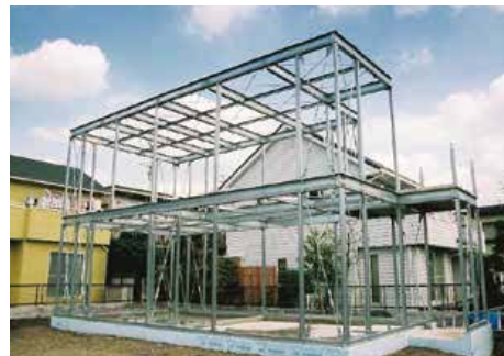
鉄骨建て方完了
