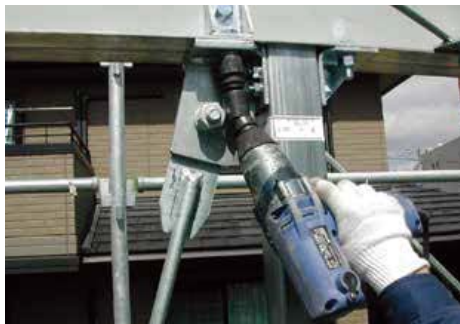
柱－梁結合部のボルト締め
