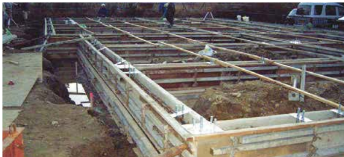
アンカーボルト取付け
