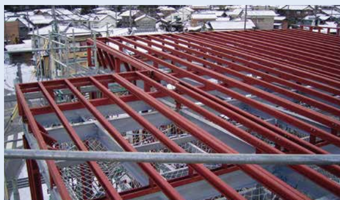
鉄骨小屋組 (片流れ屋根)
