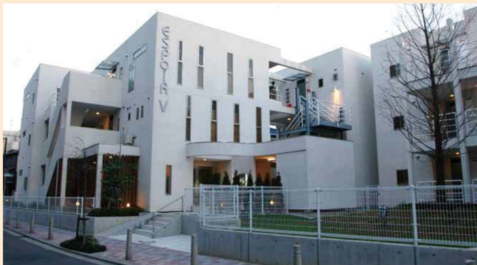
耐火建築物:3階 (1,525㎡)
