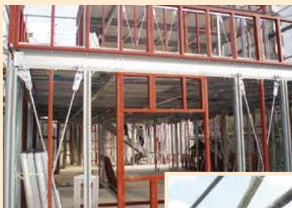
鋼製下地 (サッシ開口)
