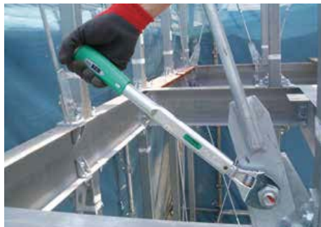
ブレース端部のボルト締め
