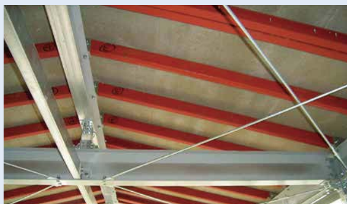
鉄骨小屋組 (切り妻屋根)
