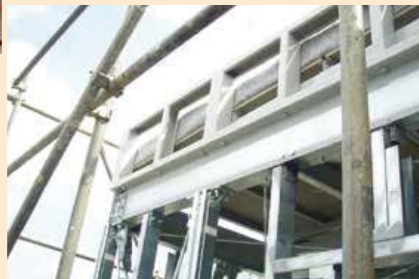
鋼製下地 (胴縁とバラベツト)
