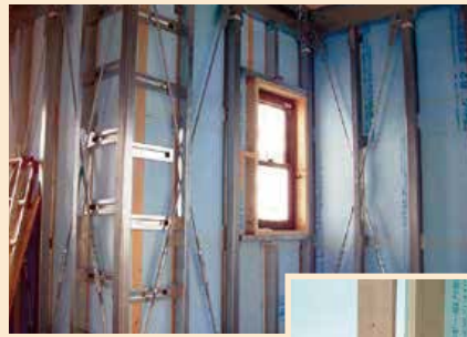
鋼製下地 (胴縁と窓サッシ)
